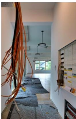
Im Zugang zum großen Saal hängen noch die Zuleitungen zum Netzwerkverteiler im Flurbereich und es fehlen noch letzte Arbeiten an der großen Elektroverteilung.
